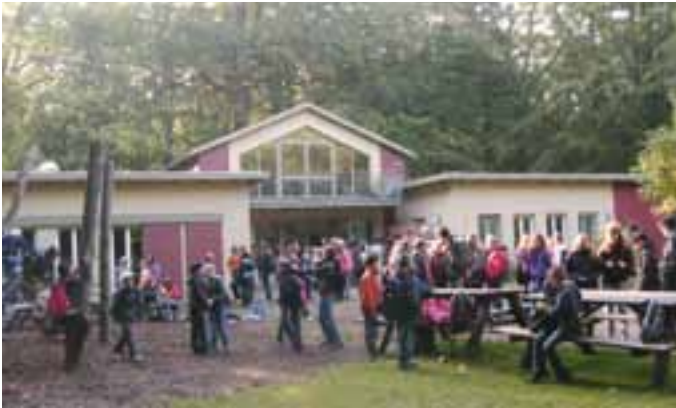
Neues Funktionsgebäude des Naturschutzzentrum (Foto: Verein)
