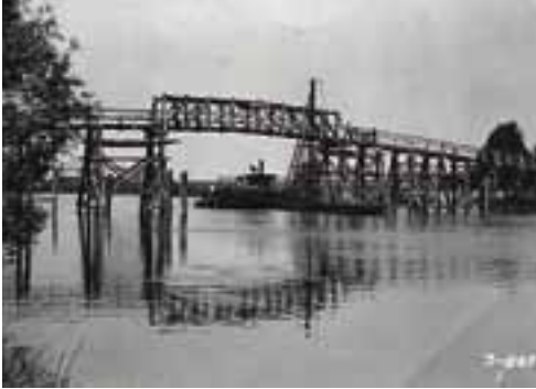
Die Arado Flugzeugwerke errichteten 1944 diese schmale Holzbrücke.
